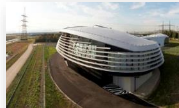
Hauptschaltwarte der APG (in 1100 Wien, Unterlaa)
